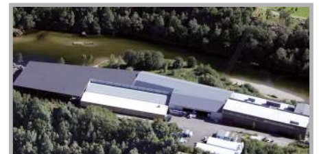
Stabilimento Noruega Norway Factory
